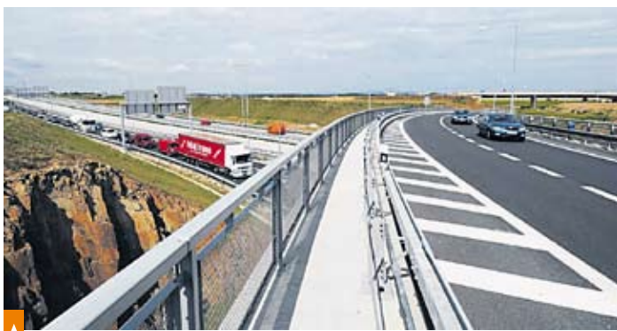
Stavba číslo 511 Běchovice – D1 v délce 12,6 km má od zastupitelů zelenou Foto: Ředitelství silnic a dálnic ČR
